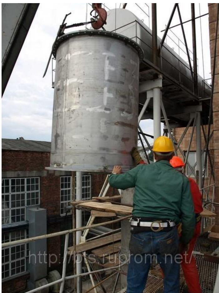
Рисунок 2 - Монтаж одной из царг колонного аппарата
