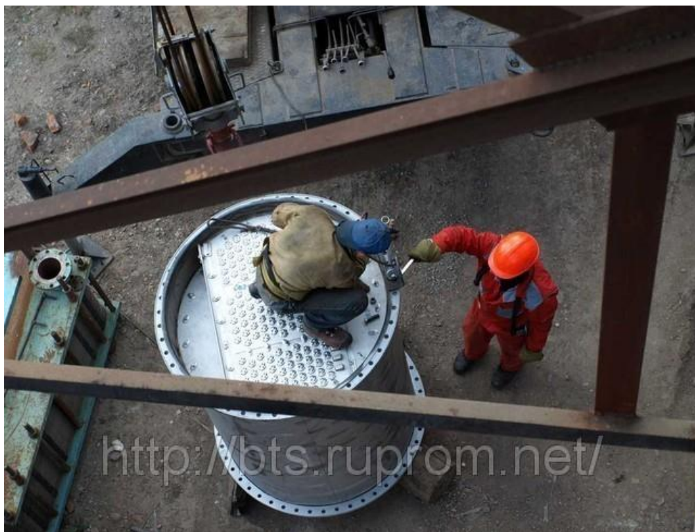
Рисунок 3 – Общий вид царги. Монтаж клапанной тарелки в царге
